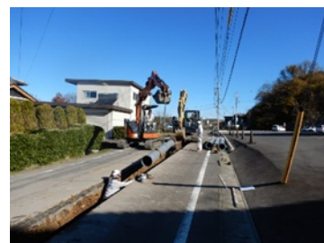
管路耐震化(更新)工事
