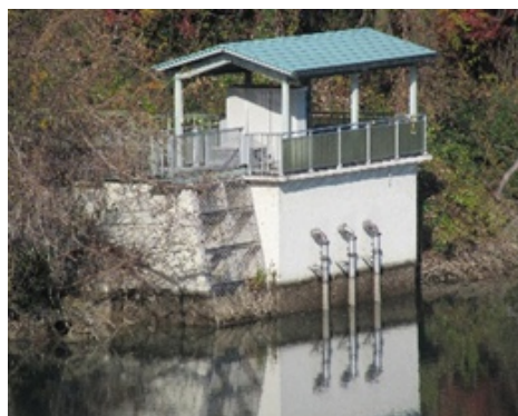
老朽化した 森山浄水場の取水施設
