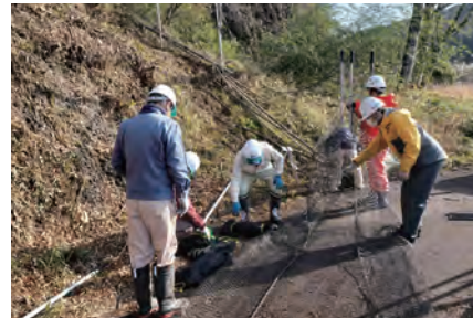
▲地域による有害鳥獣対策ネットの設置
