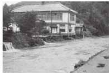
濁流で土台が流された当時の 三和連絡所（三和町川浦）
