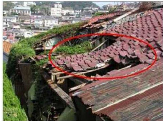
柱の変形が著しく崩壊の危険がある例
