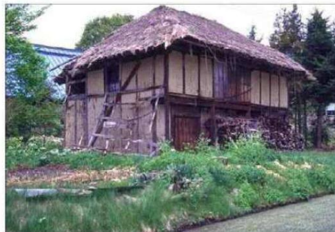
屋根材がワラの例
