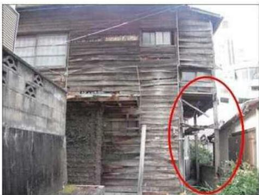
一部の柱が傾斜している例
