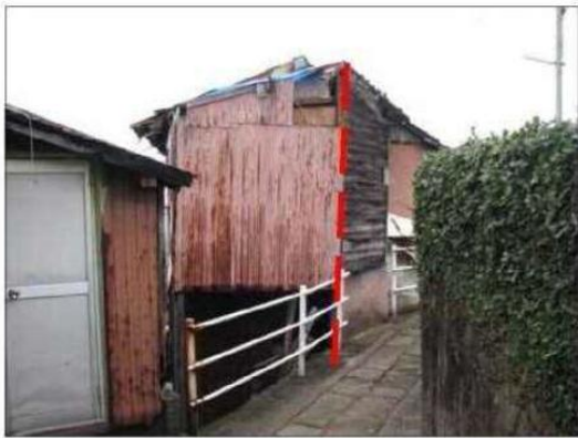
一部の柱が傾斜している例
