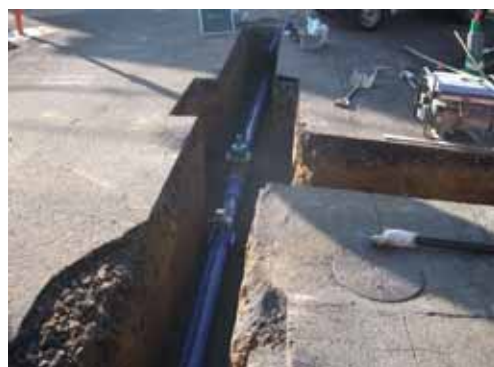
(写真) 管路の布設
