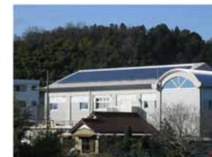
(写真) 森山浄水場の太陽光発電
